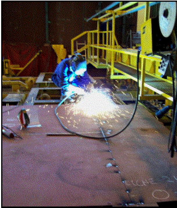
Operario realizando soldadura por punteo
