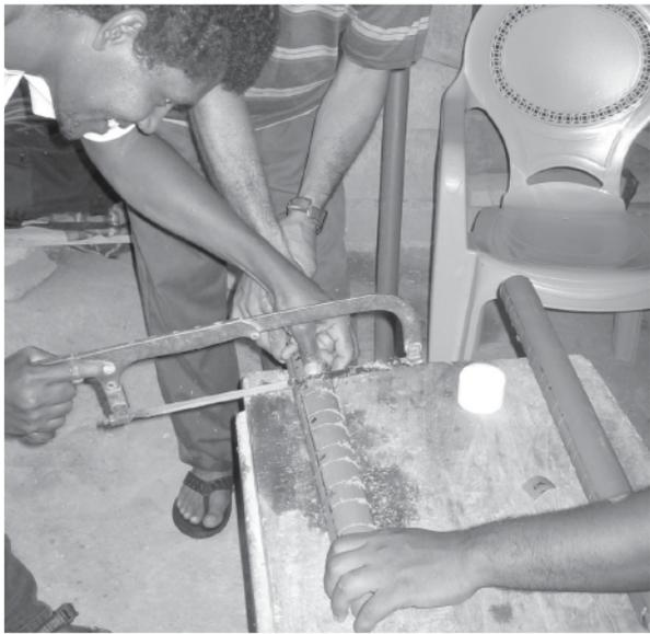
j. Ya teniendo las marcas, se procede a hacer los cortes utilizando una segueta.
