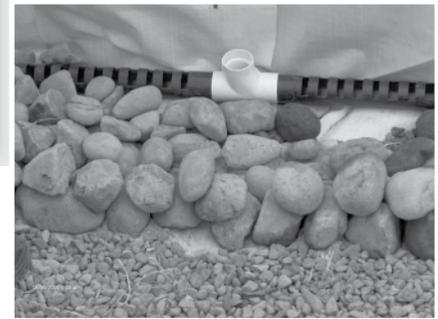
**o.** Es muy importante verificar el alineamiento de las aberturas a ambos lados de la T. Para esto es posible ayudarse con las marcas de las rayas longitudinales que tiene cada pieza de tubo.
