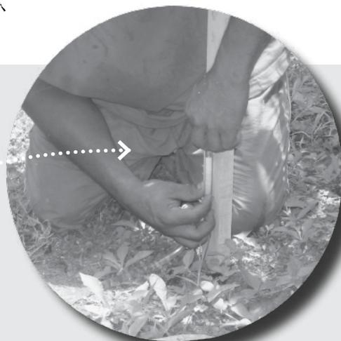
**c.** Con las estacas ubicadas en su lugar, se procede a colocar los niveles de referencia, poniendo una cuerda, a partir de un clavo en las piezas horizontales de las yuguetas, a más o menos 30 cm del suelo.
