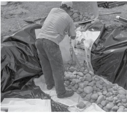
**b.** Los tramos de longitud  $L_2$  son para colocar en ellos la piedra gruesa y en el tramo central de longitud  $L_1$  se coloca la piedra de menor tamaño.
