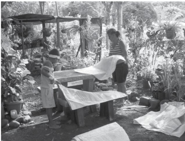
**e.** Sobre el plástico se colocan los sacos. La colocación de estos sacos se hace para cubrir y proteger el plástico, de tal manera que no se rompa en el proceso y cuando se colocan las piedras.
