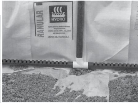
**n.** Se colocan los tapones y las T's. Se utiliza el pegamento solvente de PVC.
