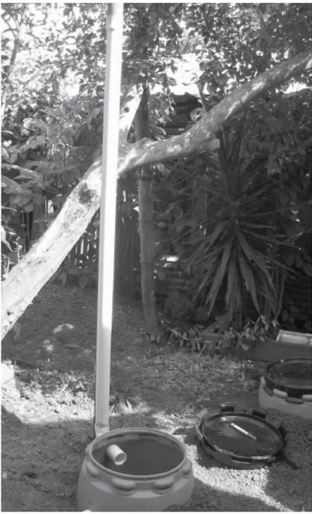
**b.** Solo en el primer recipiente se coloca la tubería para la extracción de gases. Los gases que se puedan formar en el segundo tanque, pasarán al primero por medio de la parte superior de la T de entrada.
