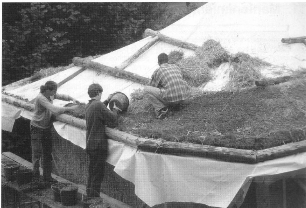
10.6 Montaje de sustrato
