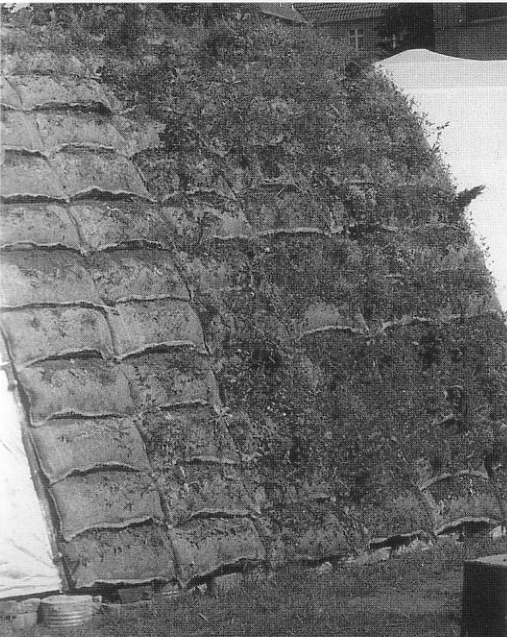
5.7 Construcción de prueba de la Universidad de Kassel (Alemania) 1977
