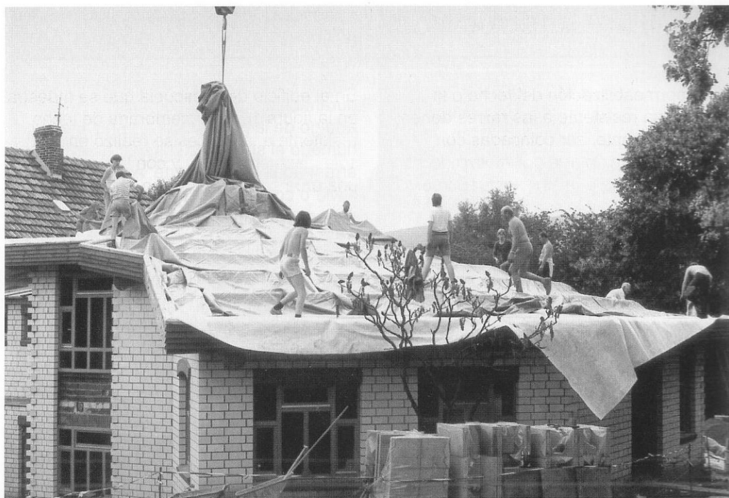
10.1 Montaje con grúa de una membrana de techo prefabricada
