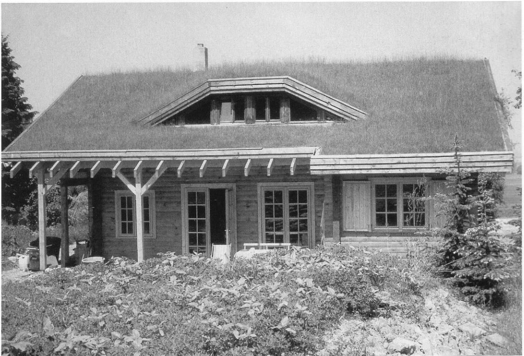
12.1 Techo de césped con lucarna integrada
