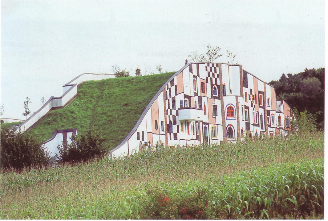
Hotel Rogner, Bad Blumau (Austria) (Arquitecto: F. Hundertwasser)
