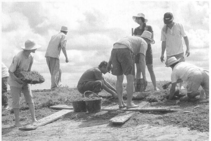
5.17 a 5.19 Realización de un techo verde de bajo costo, Viamão (Brasil)
