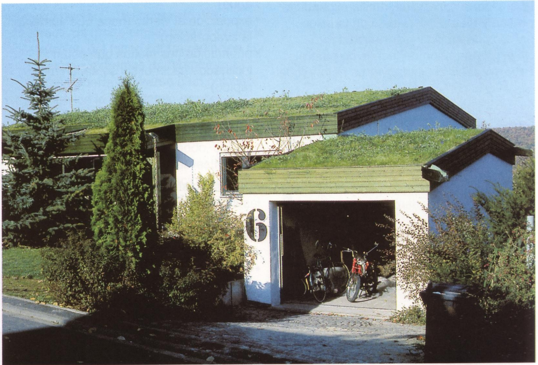
... fue sustituida por un techo verde en Kaufungen (Alemania)
