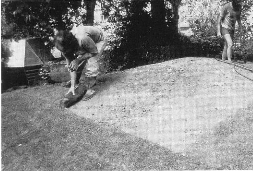
4.9, 4.10 Montaje de césped en rollo
