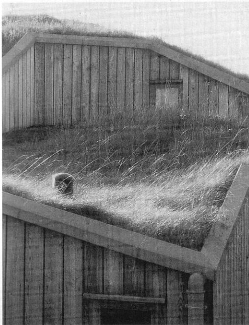
4.11 Techo verde con densa vegetación de pastos silvestres, Urbanización ecológica, Kassel (Alemania)
