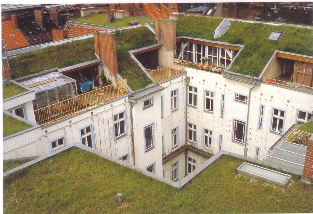
Ampliación sobre azotea con techos de césped, Berlín-Kreuzberg (Alemania)
